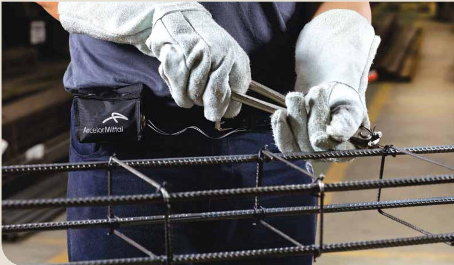
Los **Alambres de Amarre ArcelorMittal** se producen con acero de bajo contenido de carbono, lo que los hace muy maleables y fáciles de utilizar en aplicaciones que exigen pliegues o torsiones. Producidos en diámetros de 1,24 a 4,18 mm, son ampliamente utilizados en la construcción civil, principalmente para el amarre de armaduras y piezas industriales.
